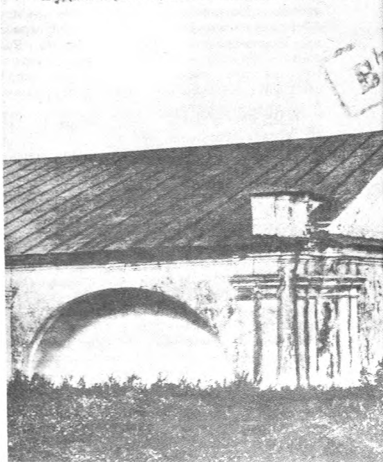
Будівництво цивільне. Біля Печерської Лаври
