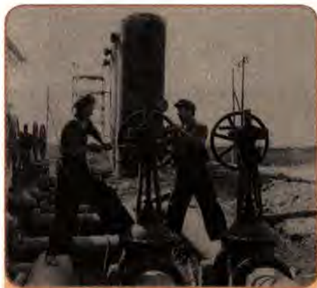
На будівництві газопроводу Дніпро- петровськ-Кривий Ріг. 1959 р.
